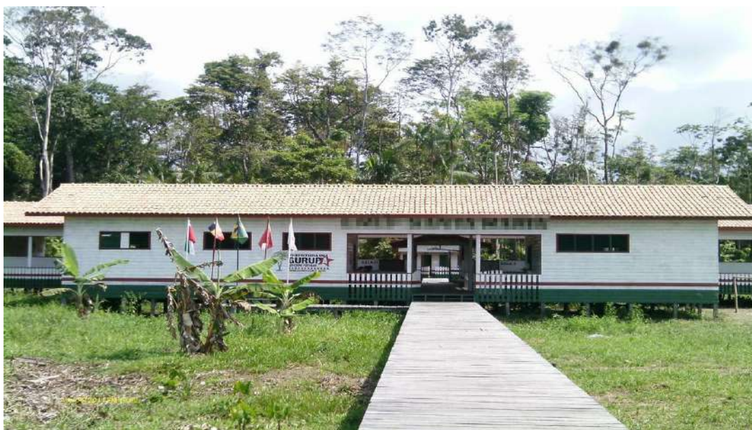
Figura 16-Localização e vista frontal do prédio da escola (Fonte: Os autores, 2020).
